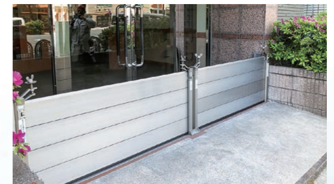
■ マンション正面出入口
