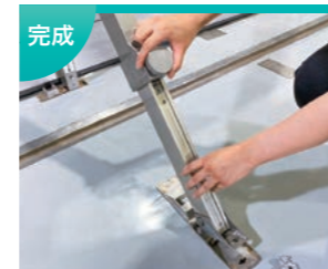
サポートの長さを調整しボルト固定します。
