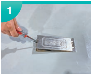
サポートベースの蓋をプラスドライバーで外します。
